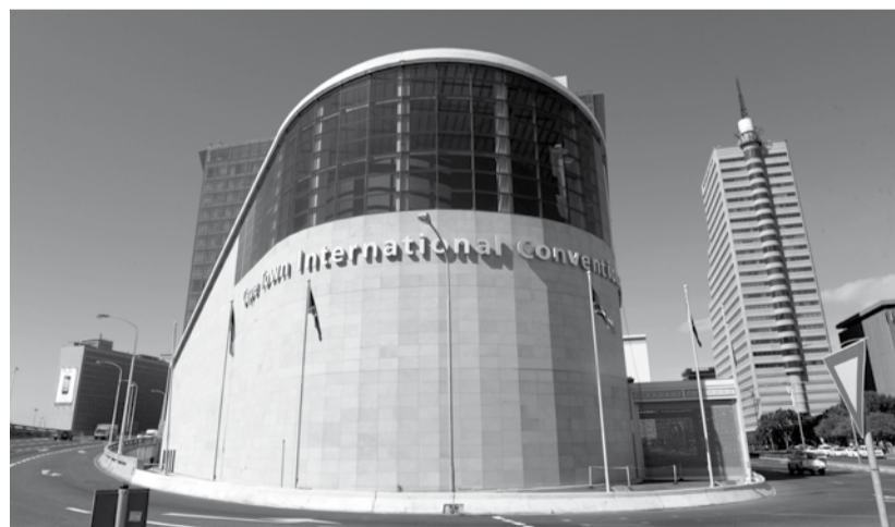
Das International Convention Centre in Kapstadt: Hier ging es los. Foto: DST/BMBF
