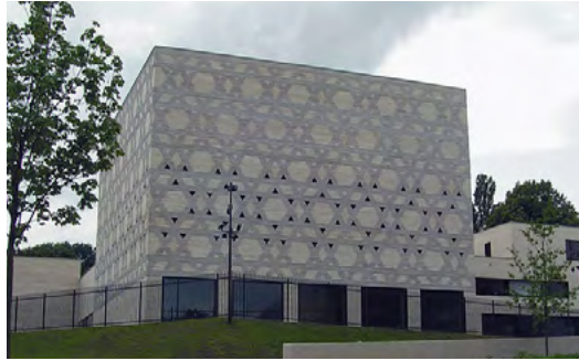
Die Neue Synagoge Bochum – ein Fenster wurde durch Schüsse beschädigt.
